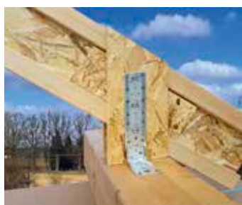
Schéma kotvení přílozek
