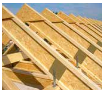
Kotvení krokve na pozednici – osedlání boční příložkou
