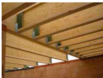
Uložení krokve na pozednici – I-nosník podložený dřevěným klínkem při větším sklonu střechy
