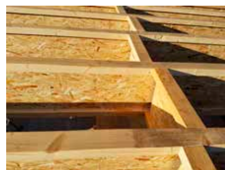
Výztuhy z výřezů I-nosníků
