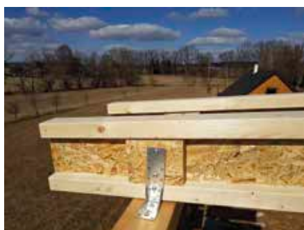
Uložení krokve na pozednici – I-nosník podložený dřevěným klínkem při větším sklonu střechy
